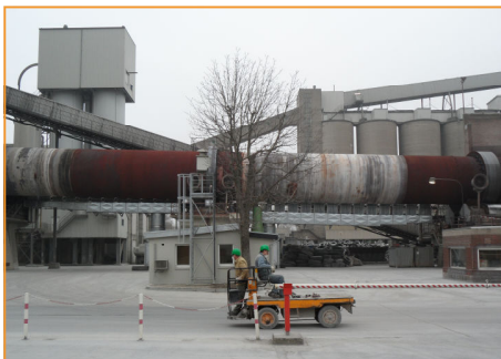
Werk Ennigerloh, HeidelbergCement AG
